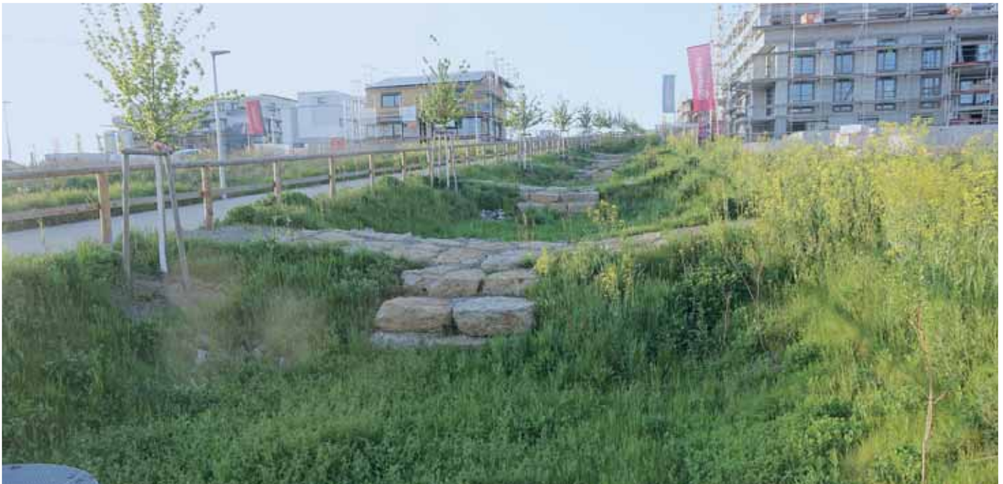
Kaskaden für das Regenwassermanagement und Retentionsbecken im Neubaugebiet »Korntal-West«
